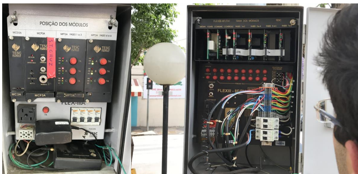
Figura 1: Controlador Semafórico em um semáforo de Paulínia.
